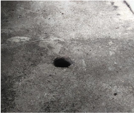
Foto 28 – Detalhe do sistema pluvial da cúpula
