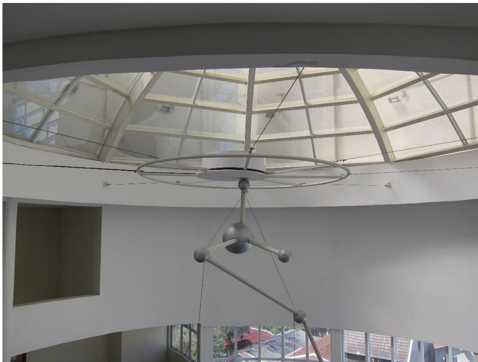
Foto 07 – Detalhe das vigas a qual o mobile está engastado
