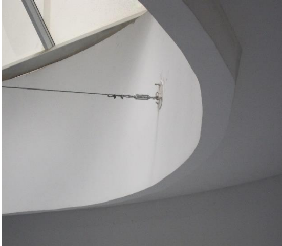
Foto 08 – Detalhe do cabo de aço ancorado na viga
